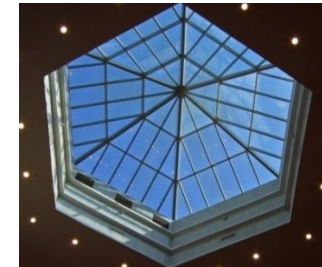
Рис. 2. Зенитный фонарь зимнего сада изнутри
