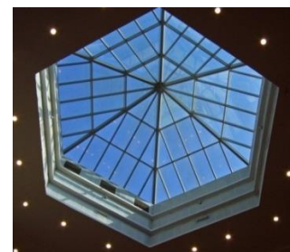
Рис. 2. Зенитный фонарь зимнего сада изнутри
